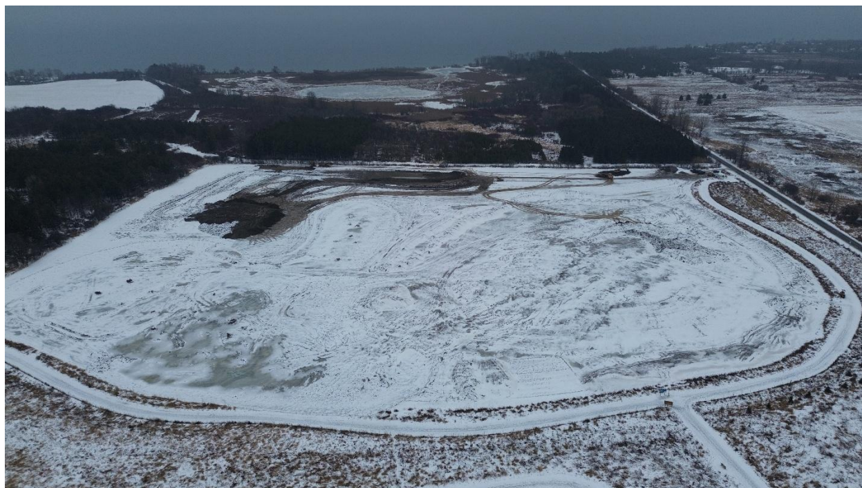
Figure 5. Le Central Lake Ontario Conservation Authority (CLOCA) prend des mesures pour améliorer la résilience côtière en créant des milieux humides sur d’anciennes terres agricoles. Le site améliorera la connectivité entre les milieux humides avoisinants tout en fournissant d’importants refuges pendant les périodes où les niveaux d’eau sont élevés et réduits (CLOCA).
