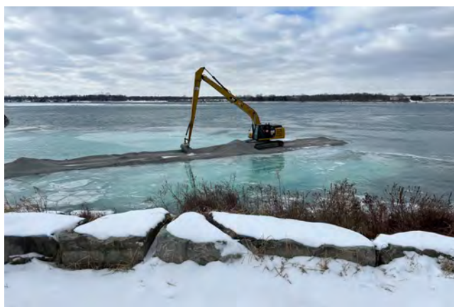
Recouvrement de sédiments contaminés dans la rivière Sainte-Claire. Source : AEC.
