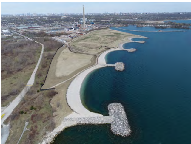
Structure de contrôle de l'érosion le long du terrain d'Ashbridges Bay. Source : Office de la protection de la nature de Toronto et de la région.
