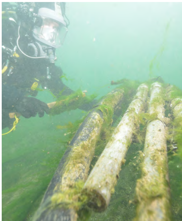
Un plongeur d'ECCC effectue l'entretien des tubes d'une pompe à une station d'échantillonnage sur place du Programme de monitoring et de surveillance de la qualité de l'eau d'ECCC dans la rivière Niagara. Source : ECCC/Section du soutien à la recherche
