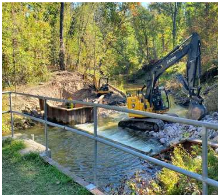
À gauche, un piège à lamproies marines et à droite, la construction en cours pour préparer le site à l'installation du piège à lamproies marines. Source : U.S. Army Corps of Engineers.
