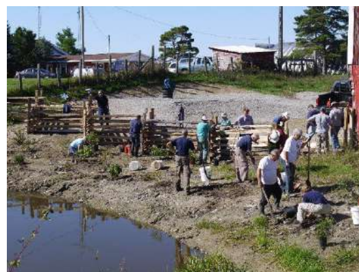
Lake Manitou Area Association et Little Current Fish and Game Club aident à installer des clôtures, des arbustes et des arbres à Green Bay Creek. Source: Seija Deschenes.
