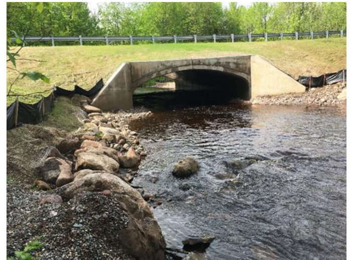
Remplacement du ponceau de Two Mile Creek – avant (en haut) et après (en bas) la restauration. (Photo : Service forestier des États-Unis)
