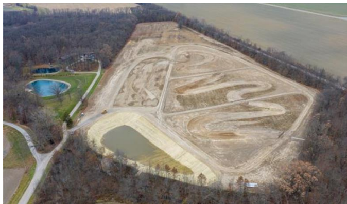
Zone humide de démonstration optimale du phosphore de l'IRGL, Defiance (Ohio). En cours de construction en novembre 2020 (gracieuseté : USACE).
