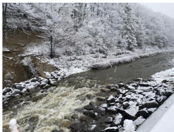
Le mur du barrage de Smith Mills avant sa démolition (Photo : StoryMap USFWS) et le mur de rocher qui a remplacé le principal mur du barrage (Photo : District de conservation des sols et de l'eau du comté de Chautauqua).
