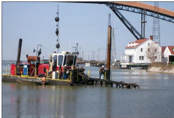
Dragage de sédiments contaminés dans le cours inférieur de la rivière Ashtabula (Photo : Ohio Lake Erie Commission).
