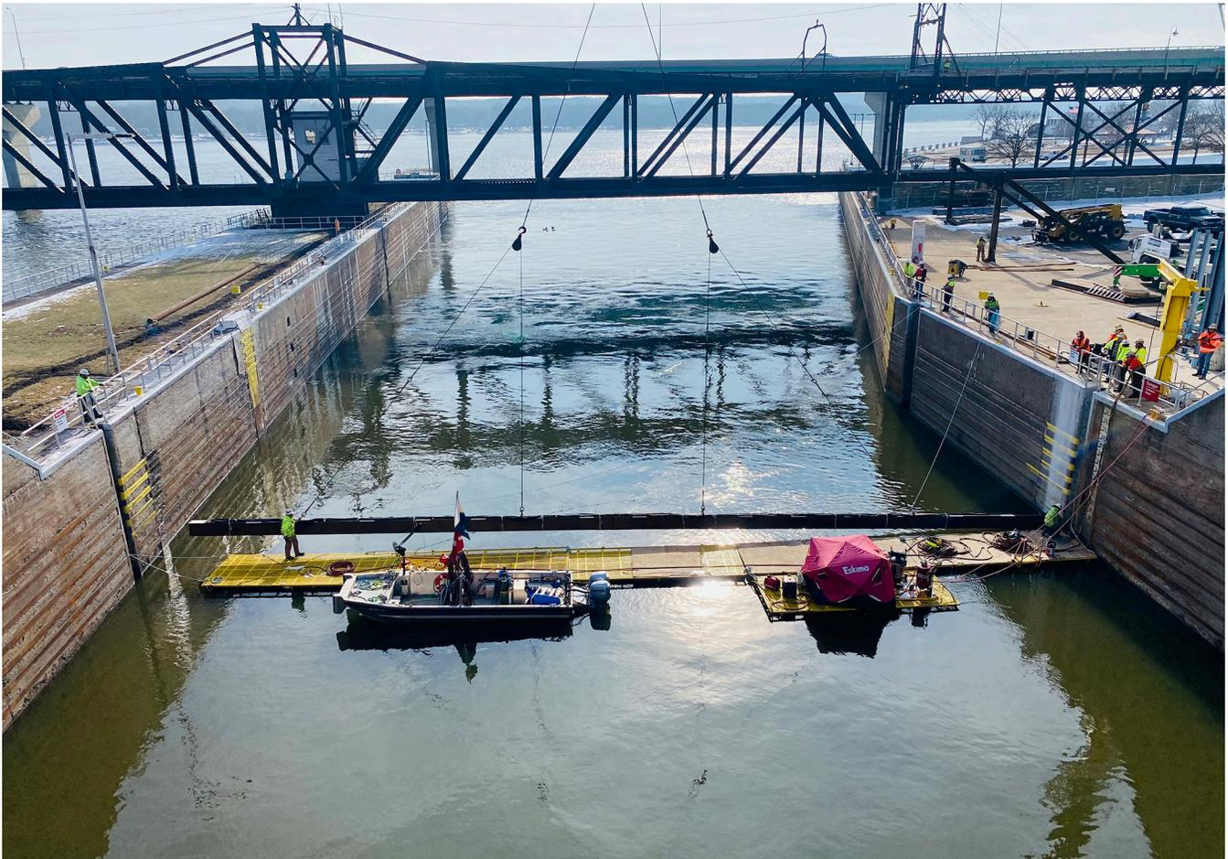
Installation d'une barre de son à plusieurs haut-parleurs à l'écluse 19 sur le fleuve Mississippi (Keokuk, Iowa), en février 2021. Ce projet met à l'essai un prototype de système de dissuasion acoustique sous-marin à un « goulot d'étranglement » connu par lequel passent les carpes envahissantes.
