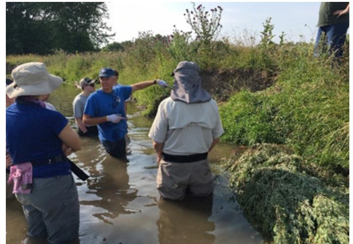
Photo de la stabilisation des berges à l'aide d'arbres de Noël mis au rebut et d'ancrages de sol. Source : NVCA.
