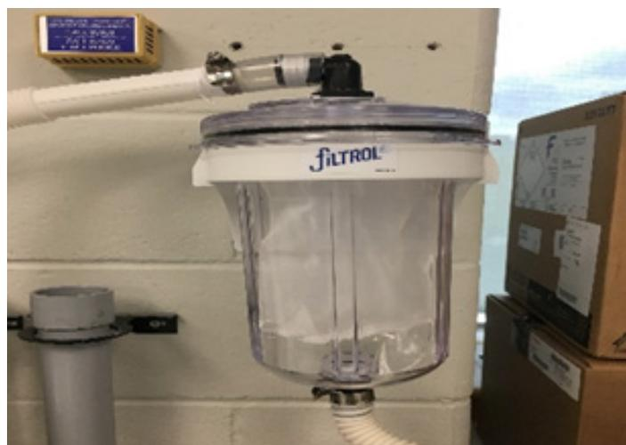
Une technologie de filtration innovante pour réduire les SCSPM et les microfibres dans le bassin du lac Huron. Source : Sam Athey.
