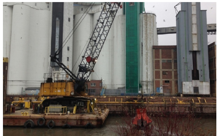
Dragage de sédiments dans le canal City Ship, SP de la rivière Buffalo (NYSDEC).
