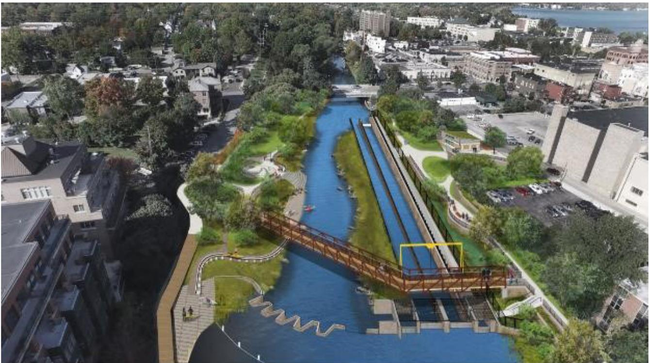
Vue d'ensemble de la conception technique à 65 % de FishPass avec un canal adaptatif de triage du poisson (à droite) et un canal de dérivation naturel (à gauche). Le passage et le débit du poisson sont régulés à FishPass par un déversoir à labyrinthe en arc de cercle (en bas à gauche) et un double système de vanne hydraulique (en bas à droite). Source : USACE, Ville de Traverse City, GLFC et AECOM.
