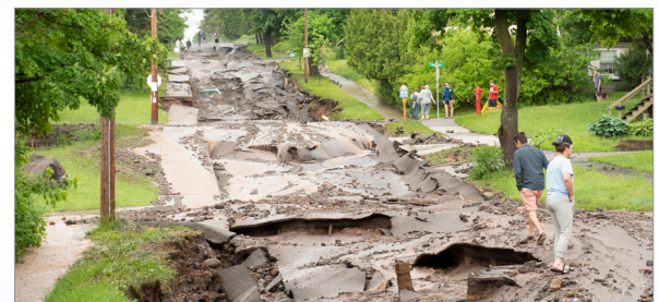
Photo : Dommages causés par les inondations à Houghton (Michigan) (Source : David Archambeau)
