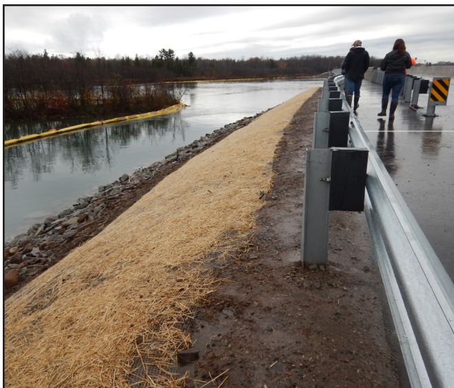
Restauration à Little Rapids, au Michigan. Photo: Communauté indienne de Bay Mills.
