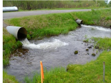
Le ponceau (en haut, avant) du ruisseau Menge a été enlevé pour rétablir l'écoulement naturel (en bas, après). Photos : Keweenaw Bay Indian Community.
