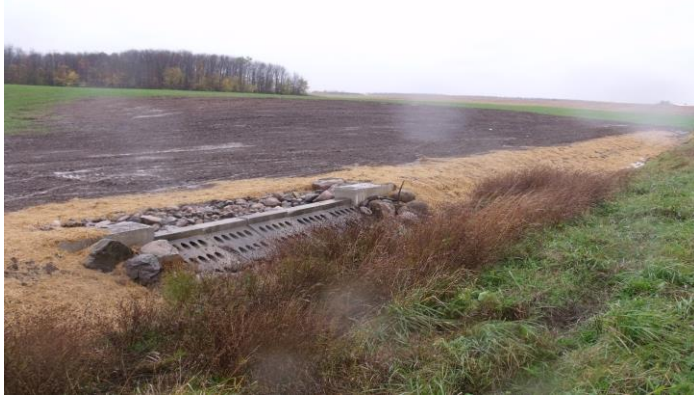
Aménagement d'une berge en terre avec un drain et une voie d'eau enherbée. Photo: Pine River Watershed Initiative Network.
