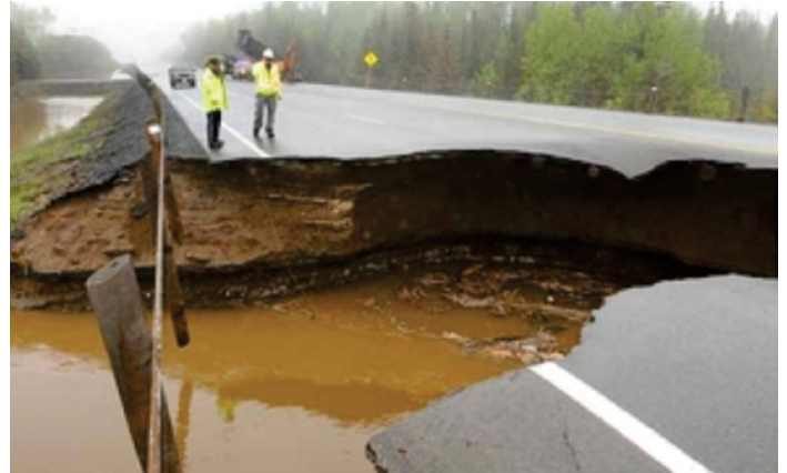
Thunder Bay, en Ontario, a été déclarée région sinistrée en juin 2012 après qu'une pluie torrentielle ait détruit les routes et inondé des maisons, des commerces et les installations municipales de traitement des eaux usées. (Photo : Chronicle Journal)
