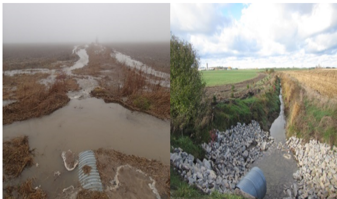
Images avant et après l'aménagement d'une tranchée et d'un piège à sédiments dans le cadre d'un projet de canalisation municipale (Office de protection de la nature de la vallée de la Maitland).
