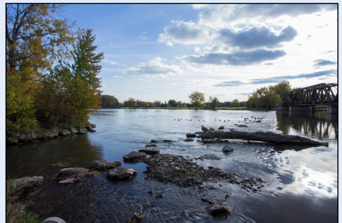
Rampe en arche de pierre dans la rivière Raisin qui fournit une passe à poissons à travers le SP de la rivière Raisin et au-delà. Photo : Ville de Monroe.
