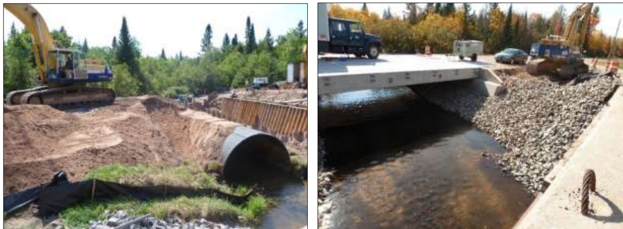
Photo du haut : ponceau de River Falls sur la route Golf Course, comté de Baraga, au Michigan, avant l'enlèvement du ponceau. Photo du bas : la route Golf Course de River Falls après l'enlèvement du ponceau. Photo : E. Johnston, Keweenaw Bay Indian Community.
